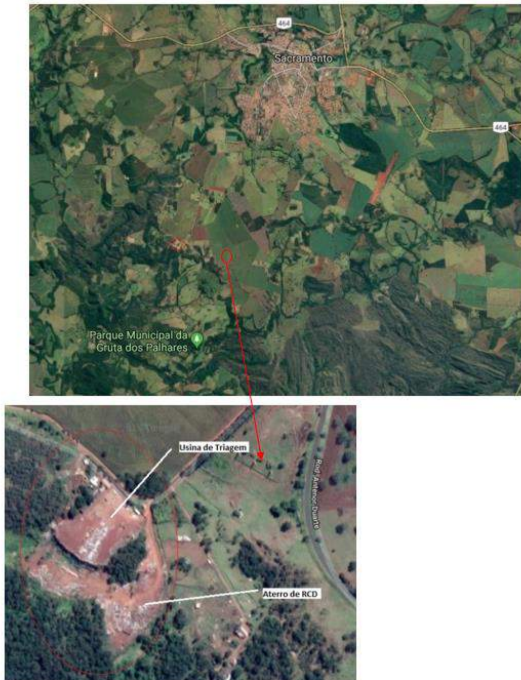
Figura 56: Aterro de RCD e Usina de Triagem do município de Sacramento
