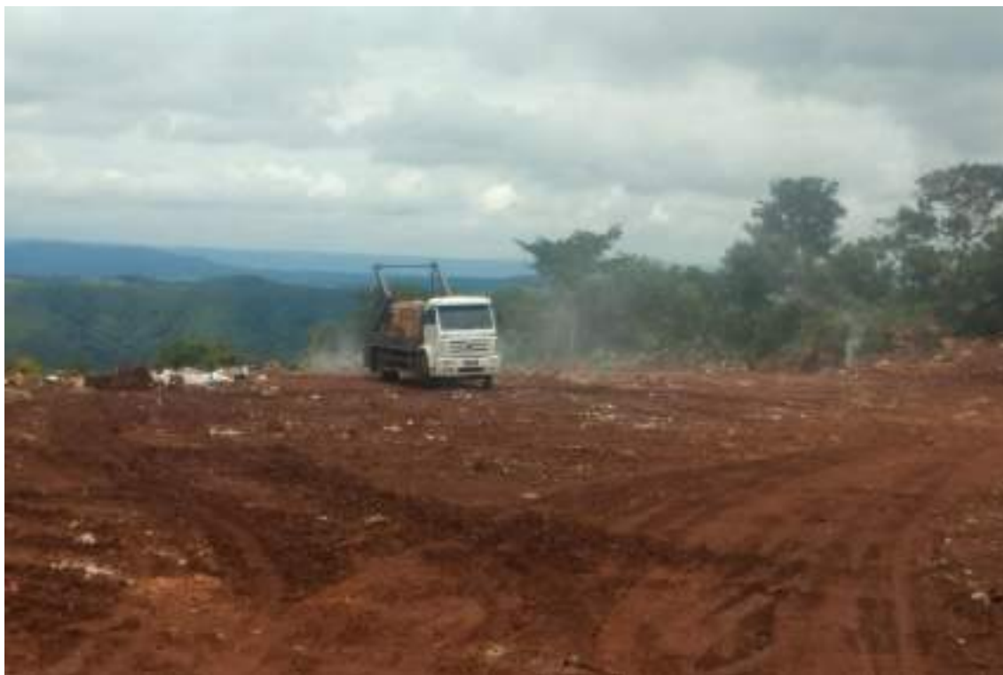
Figura 57: Visão Geral do Aterro de RCD de Sacramento
