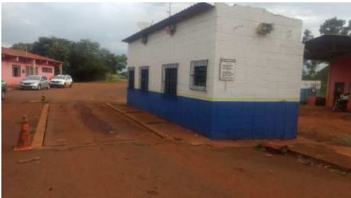
Figura 50: Aterro Municipal de Uberaba: Balança em primeiro plano, área administrativa à esquerda e setor de apoio operacional à direita
